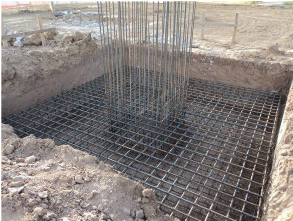
Base cuadrada con armadura + armadura de columna
